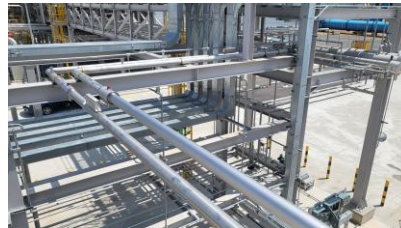
국내최초 하이창원(두산중공업) LH2플랜트 진공단열배관 제작/설치공사
